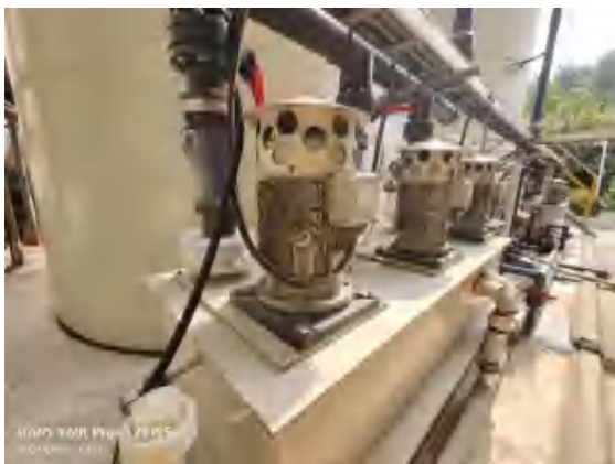
图 4-19 产噪设备设置减震底座
