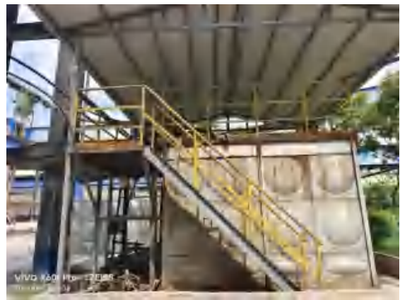
图 4-18 综合利用单元渗滤液暂存设施
