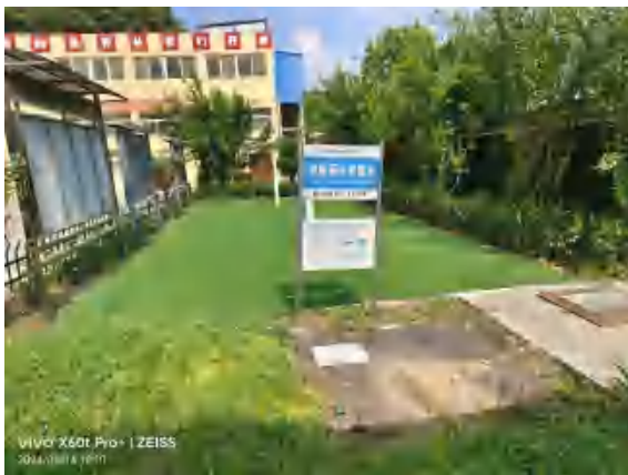
图 4-13 初期雨水收集池（150 m 3 ）
