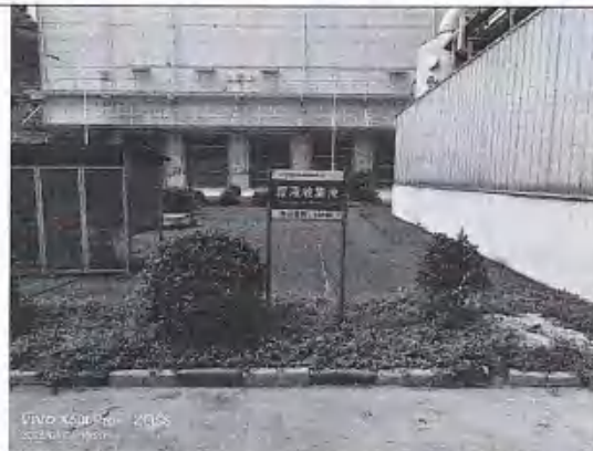
华新南漳再生资源利用有限公司现有 1#事故应急池（400m 3 ）
