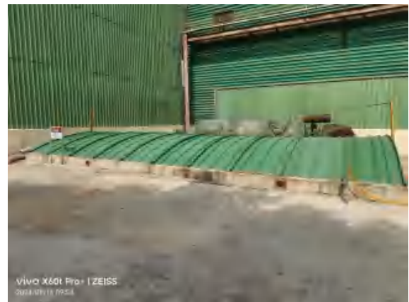
图 4-14 渗滤液收集池（420 m 3 ）
