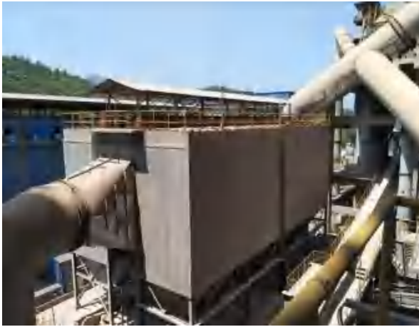
图 4-11 窑尾布袋除尘器
