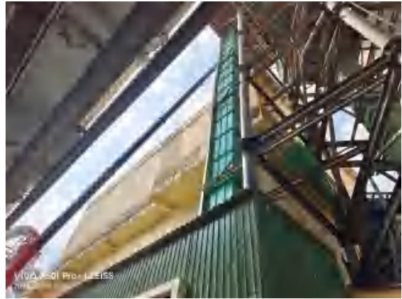
图 3-6 综合利用单元 RDF 入窑提升装置（新建）
