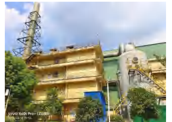
图 4-7 除臭楼+排气筒
