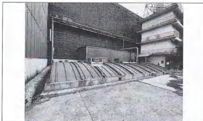
华新环境工程南漳有限公司现有渗滤液收集池（420m 3 ）
