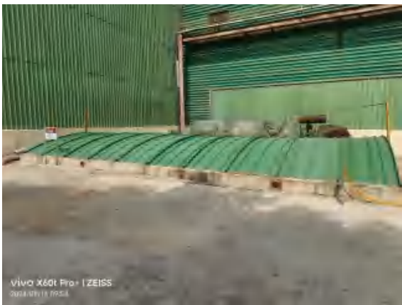
图 4-4 渗滤液收集池加盖密封
