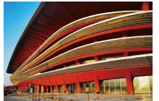
华新超可隆® 超高性能建筑幕墙板应用于西安国际足球中心
