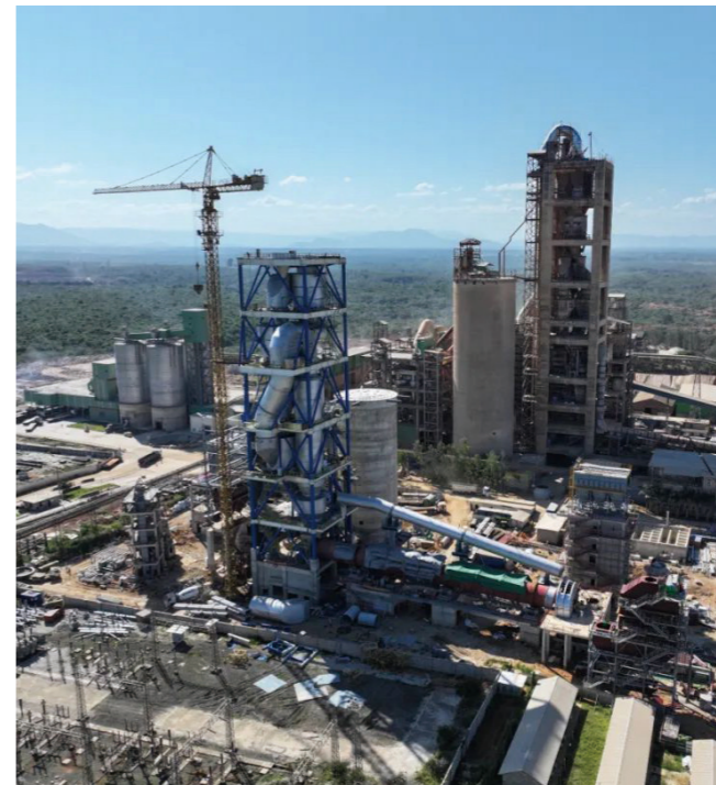
2023 年 9 月 28 日，华新坦桑尼亚马文尼公司二期新型干法生产线项目预热器安装顺利封顶，已于 2024 年 1 月建成投产
